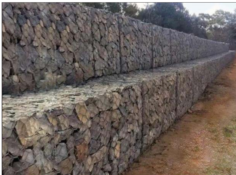
Figura 11 Immagine tipologica delle gabbionate
