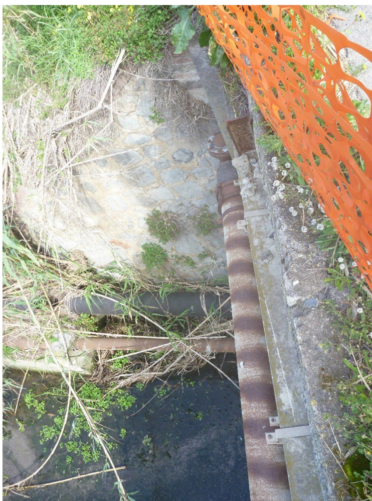
Sottoservizi individuati a valle del tombato e all'interno del ponte della SS
