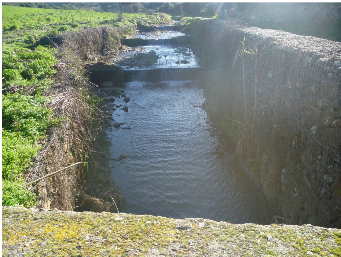
Foto delle soglie presenti a monte nel tratto a cielo aperto in corrispondenza delle gabbionate.
