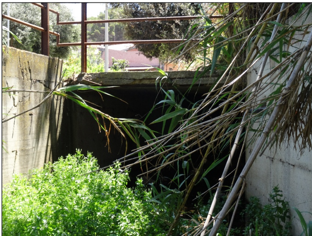
Foto 17: Particolare dell'imboccatura del canale tombato verso valle
