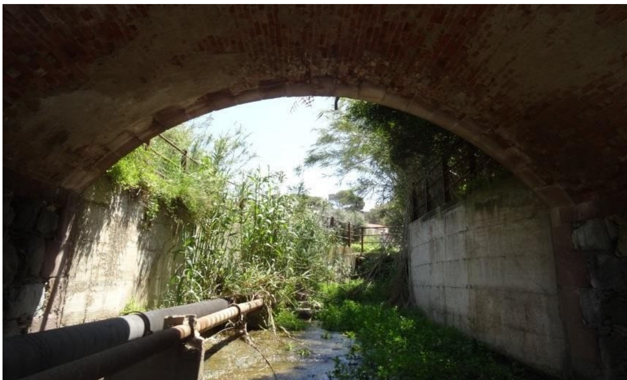
Sottoservizi individuati a valle del tombato e all'interno del ponte della SS
