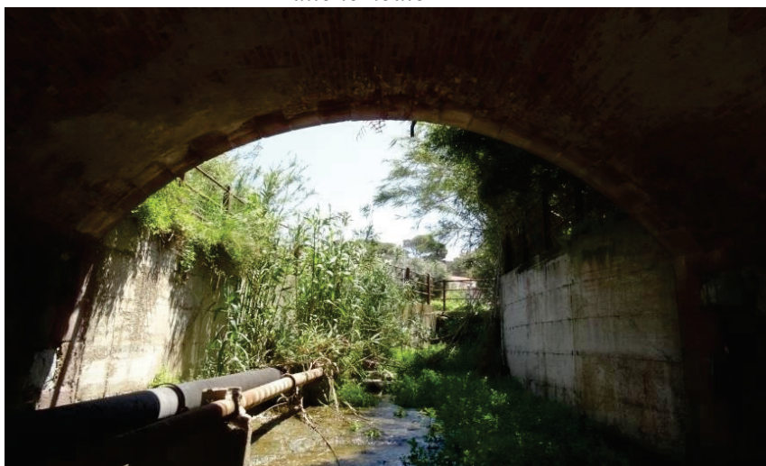
Sottoservizi individuati a valle del tombato e passanti all'interno del ponte della SS 292
