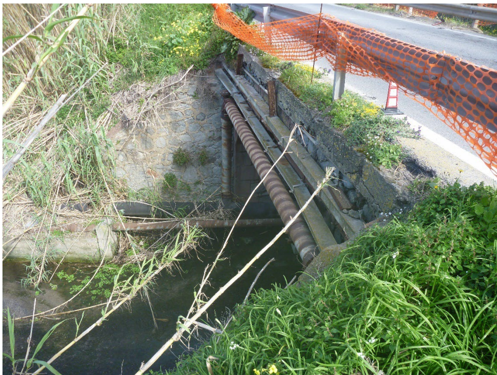
Tubazioni che passano di fianco e sotto il ponte arco.
