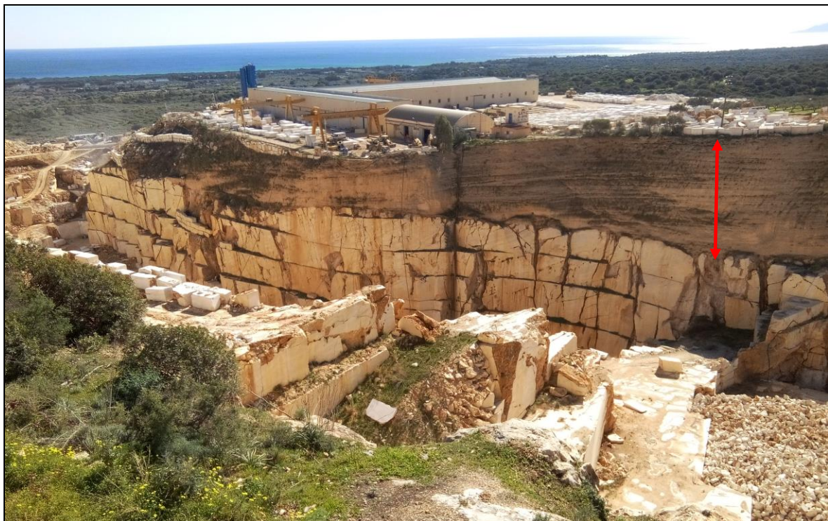
-Strato di ricoprimento del giacimento in un altro settore del comparto estrattivo di Canale Longu- Si può notare la parete verticale di oltre 24 metri di altezza, sistemata e stabile senza necessità di contenimento
