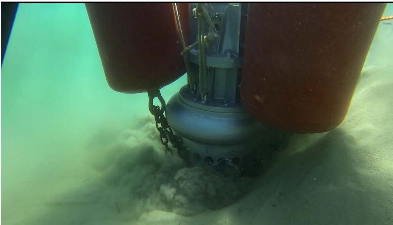
Figura 6 pompa Dragflow durante i lavori di rimozione dei geotubi
