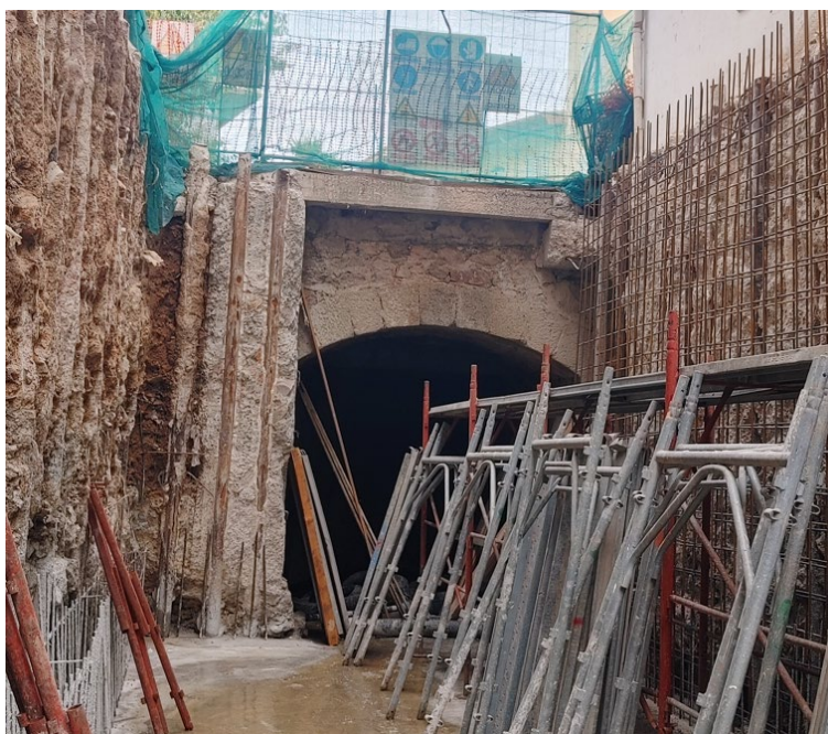
Figura 4 – Larghezza del ponte in essere rispetto al canale in fase di realizzazione
