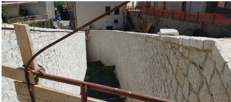
Figura 7 – Tratto di canale rivestito con materiale granitico
