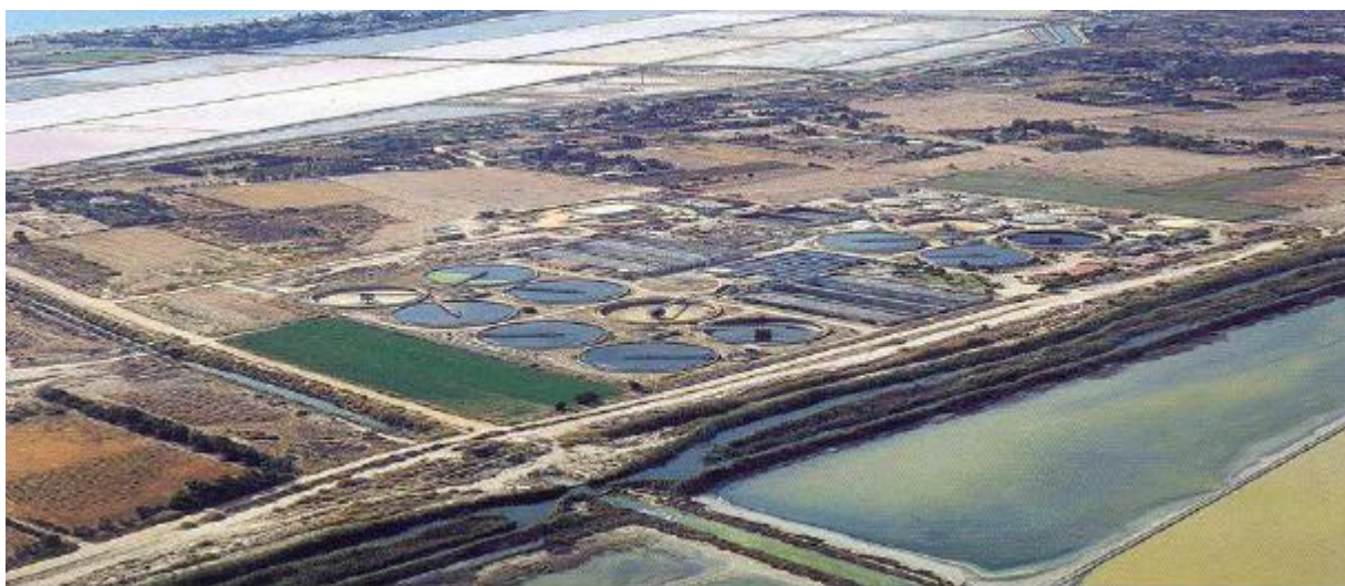
Figura 10: L'impianto di depurazione di Is Arenas
