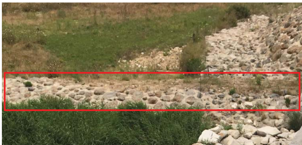
Figura 39 – Protezione con massi cementati del fondo alla nuova campata.
