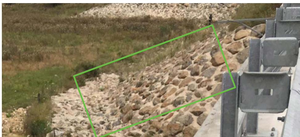
Figura 40 – Difesa spondale dei rilevati di approccio alla nuova campata.
