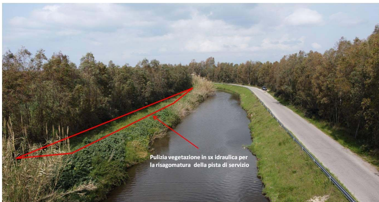
Figura 35 Pulizia della vegetazione necessaria alla risagomatura della pista di servizio per l'accesso al canale in sinistra idraulica
