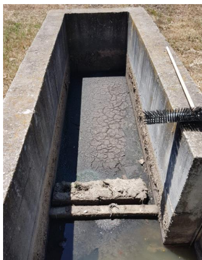
Figura 5 – Assenza del collegamento idraulico del pozzetto di sfioro B verso il “vecchio sfioro”
